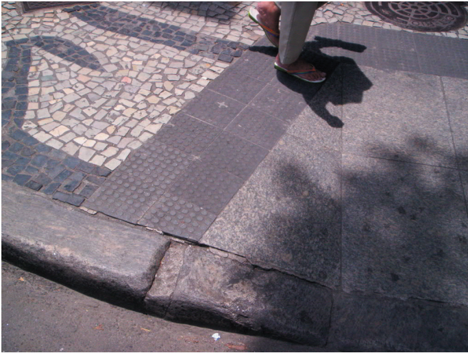
Piso de Ladrilho Hidráulico 49 Esferas 20 x 20 cm, Podotátil, antiderrapante, autotráfego e de fácil limpeza, preto, delimitando rampa para deficientes visuais e pedestres em geral.
