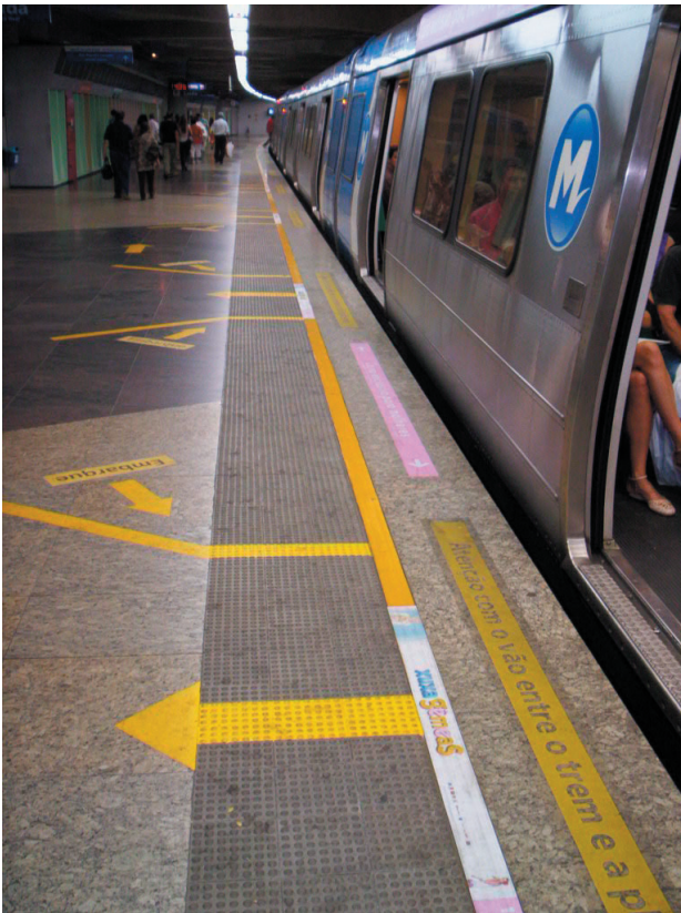
Piso de Ladrilho Hidráulico 49 Esferas 20 x 20 cm, Podotátil, antiderrapante, autotráfego e de fácil limpeza, preto, delimitando área de entrada e saída nos vagões do metrô Rio de Janeiro na estação de Copacabana .
