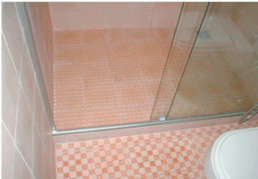
Piso de banheiro em Ladrilho Hidráulico 20 x 20 cm, decorado, linha geométrica, modelo Baguá nas cores Pêssego Citrino nº 08, Marfim nº 33 e Verde Desmaiado nº 26 Piso de box em Ladrilho Hidráulico 20 x 20 cm, Linha Antiderrapantes 49 Esferas na cor Amarelo Pantone
