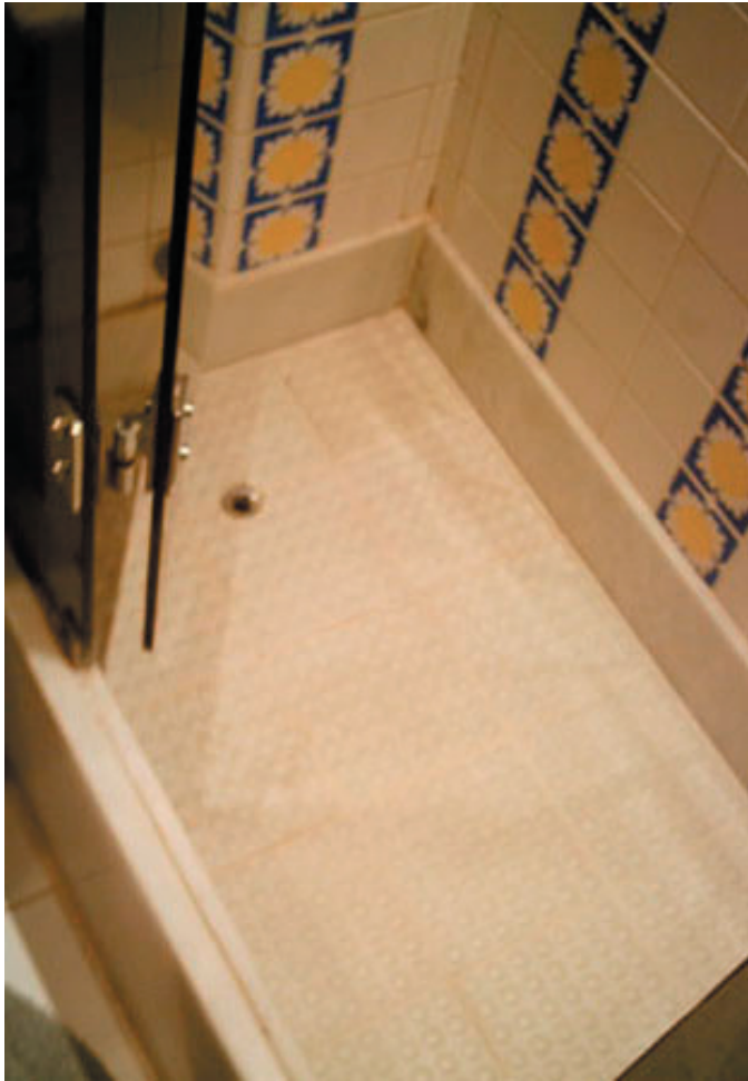
Piso de box em Ladrilho Hidráulico 20 x 20 cm, Linha Antiderrapantes 49 Esferas na cor Branco Diamante.
