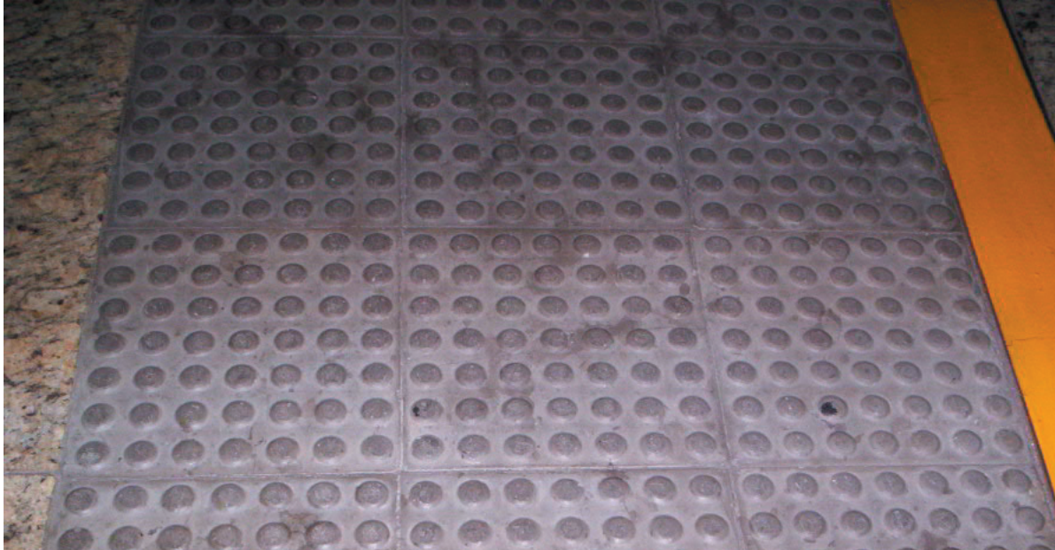
Fotos em detalhe do piso do metrô. Fotos anteriores.
